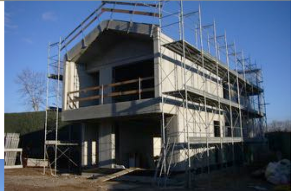
Struttura edificio completata
