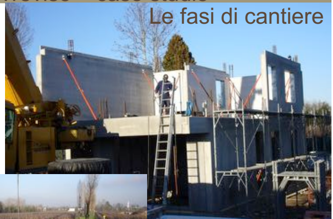
Posa dei pannelli del primo piano
