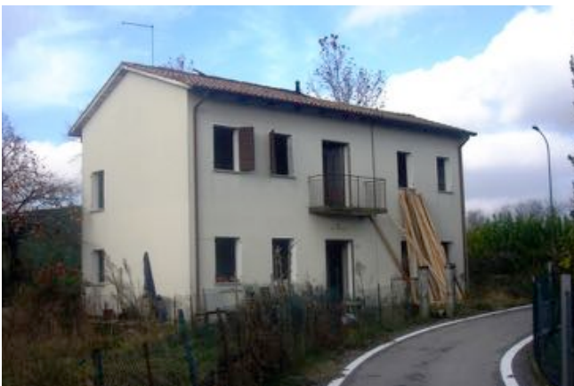
Vista dell'edificio prima dell'intervento
