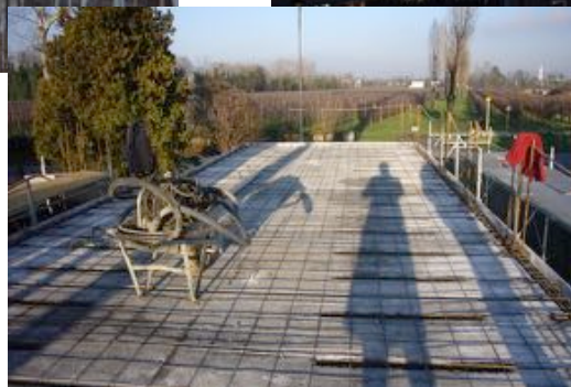
Posa del solaio del primo piano
