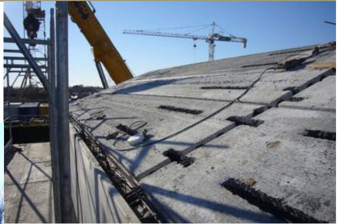
Posa solaio di copertura
