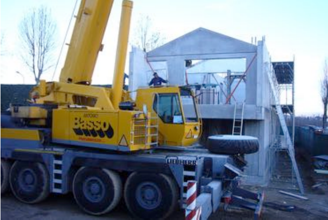
Posa pareti trasversali primo piano
