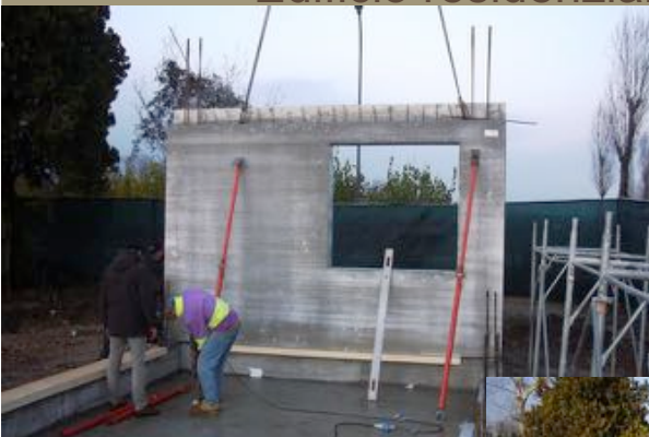
La posa del primo pannello
